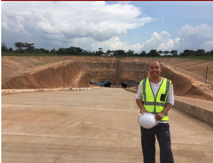
图 16 坎索克矿区斜井井口完成建设
